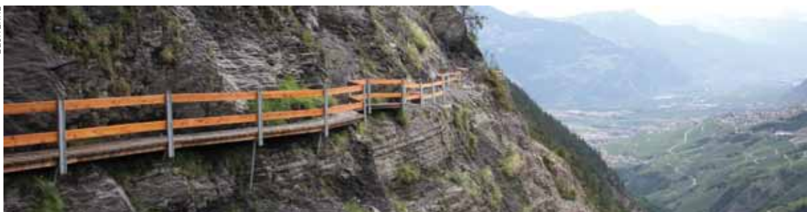
Réhabilitation du Bisse de Savièse (appelé également Torrent-Neuf). Un des projets soutenus par le FSP.
